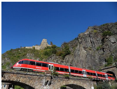
Ahrtalbahn bei Altenahr vor der Zerstörung Foto: Eißer
